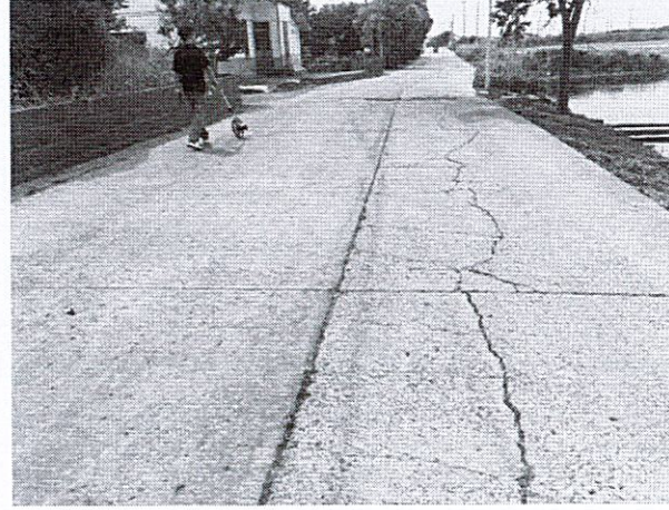
K0+945 沿河侧板块连续破碎板
