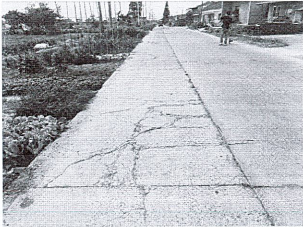
K0+300-330 段拼宽板块连续破碎板
