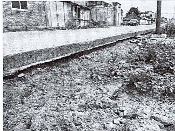
K0+460 拼宽板块破碎板、基层脱空
