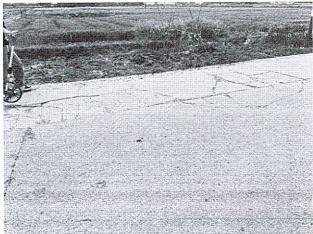
K0+300-330 段拼宽板块连续破碎板
