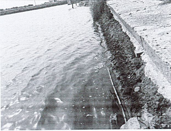
K1+731~K1+771 段左幅河塘段路基塌方
