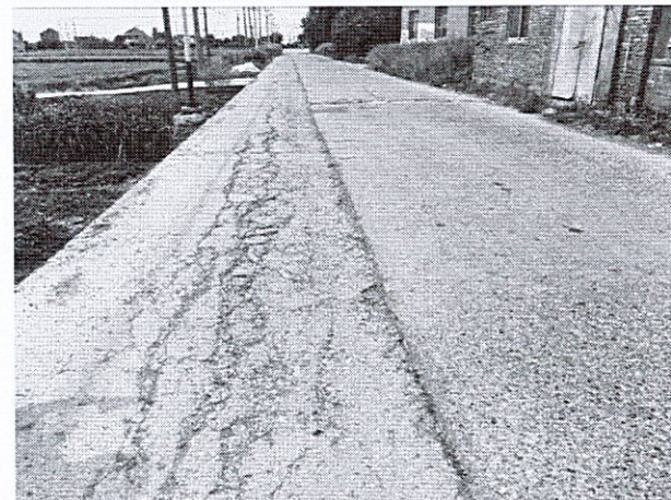
K0+460 拼宽板块破碎板、基层脱空
