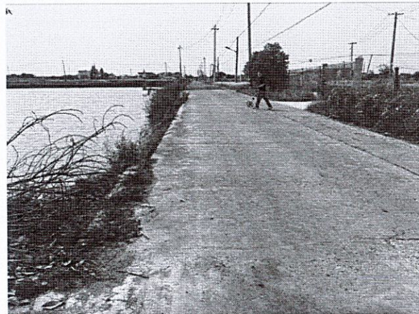
K1+730-771 终点段南侧拼宽板块塌陷及连续破碎板
